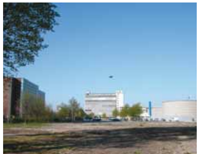
Byggegrunden set fra Puggaardsgade. Hotel Marriott, Falckhuset og politiets garageanlæg ses i baggrunden.
